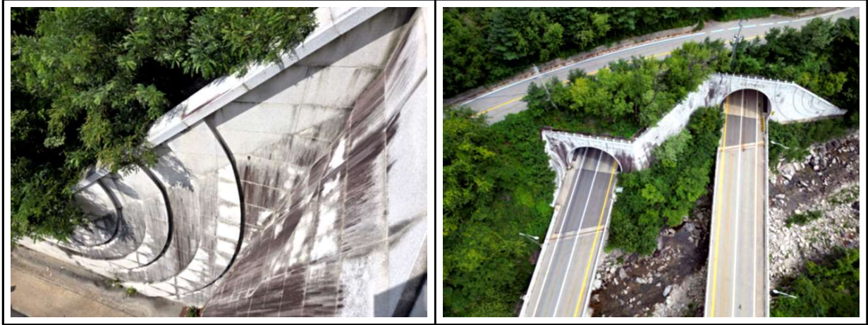
【사진 1.3.11】 옹벽 전경
