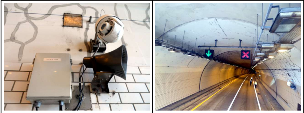
【사진 1.3.19】 기타부속시설 전경
