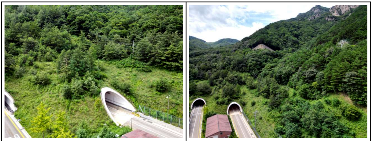
【사진 1.3.9】 사면 전경
